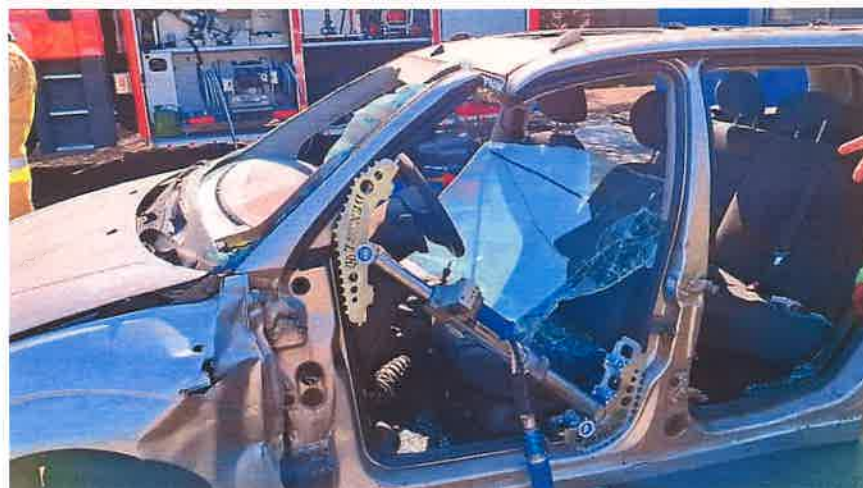
Fot. 10 i 11. Zastosowanie wspornika kąтового 80° i 120° Źródło: CNBOP-PIB.
